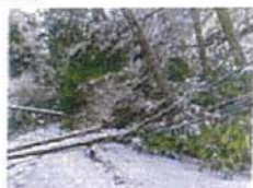
県道38号被害状況
