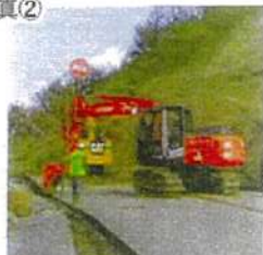
国道249号緊急復旧
