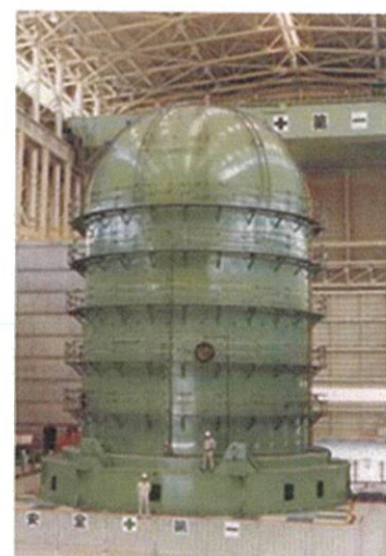
PWR原子炉格納容器 鋼製 〔縮尺:1/3.7. 重量:350t(実機:約3,800t)〕
