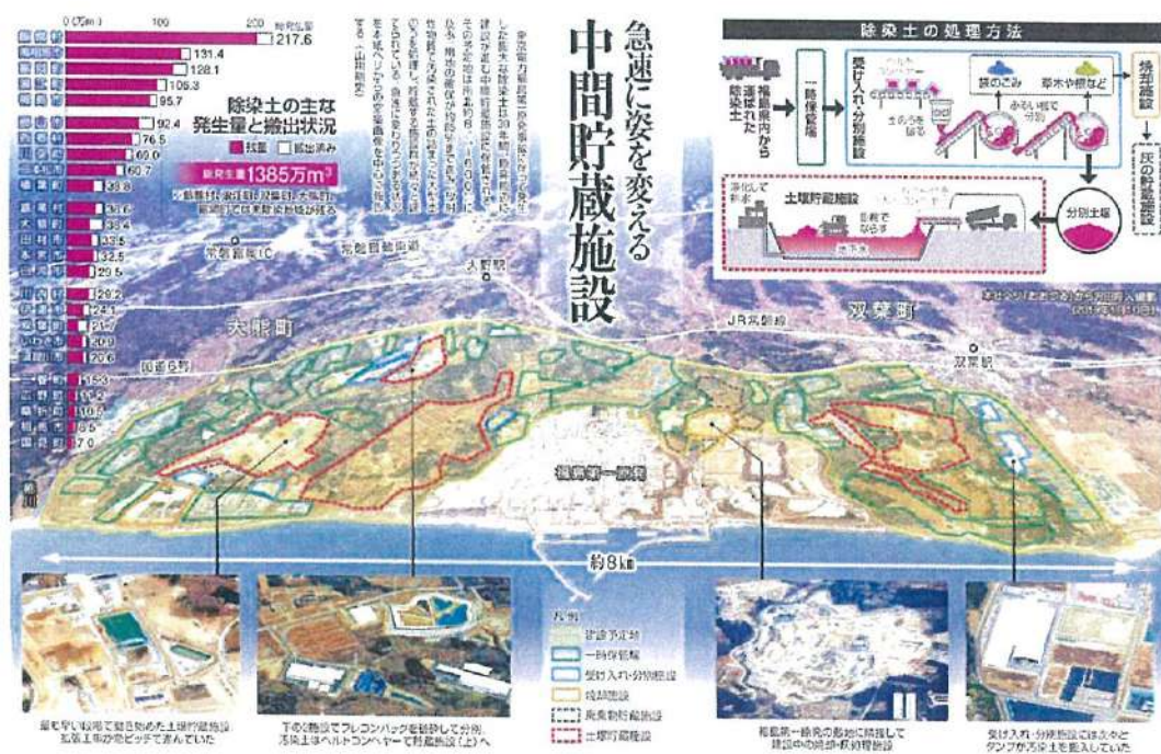
【出典】東京新聞 HP 急速に姿を変える中間貯蔵施設 30
