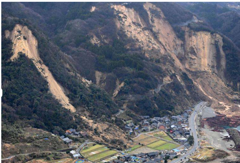
(甲 B 1 5 2・珠洲市、1月3日・国道249号線が寸断)
