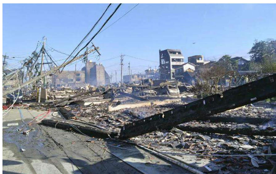
(甲 B 1 4 9・1月2日撮影、輪島市の火災現場)
